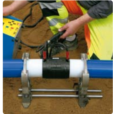
8. Toteuta sen jälkeen sähköhitsaus.
