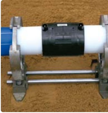
6. Asenna hitsauskaapelit. Muhvi on nyt valmis hitsattavaksi.
