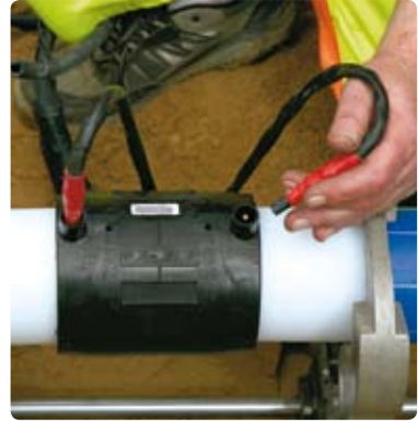
6. Asenna hitsauskaapelit. Muhvi on nyt valmis hitsattavaksi.
