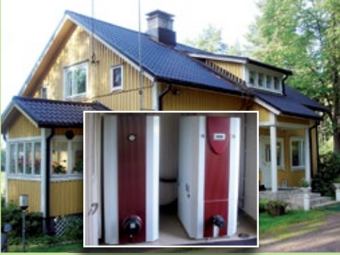
Öljykattila vaihdettiin maalämpöpumppuun SIKH 9 TE
