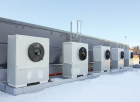
Osion Eteläpuolella Norjassa sijaitsevaa lääketehdasta lämmitteää 5 kpl Dimplexin LA35TUR+ ilma-vesilämpöpumpua.
