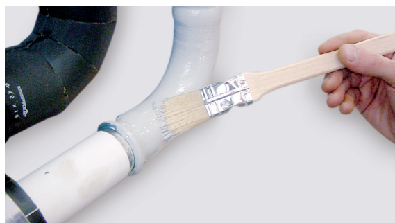
Kuva 24 - Liitäntöjen ja putkien päällystys pohjusteella.
