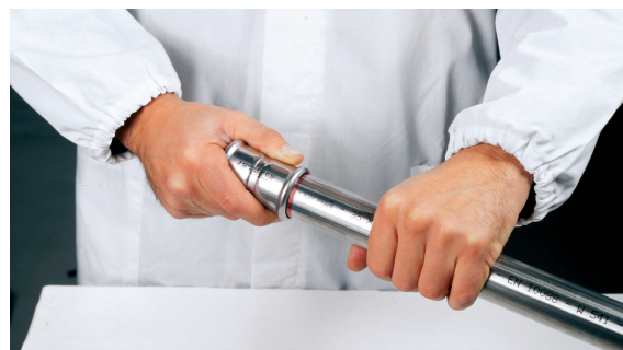
Kuva 21 - Putken työntäminen puristusliittimeen
