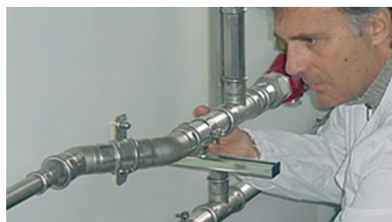
Kuva 23 - Puristusliitoksen tarkastaminen
