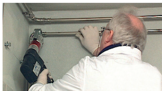
Kuva 22 - Puristusliitoksen tekeminen
