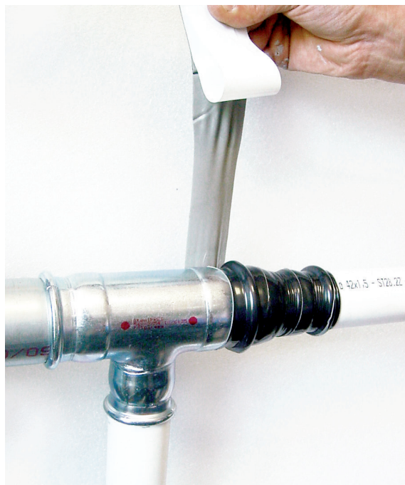
Kuva 25 - Liittimien suojaus butanoliteipillä.
