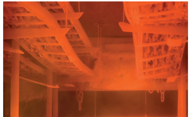
Polttuunin lämpötilä 60min palokokeen alkamisesta on noin 950°C. Kuvassa vasemmalla alempana oleva tikashylly on kannakoitettu 2m välein, ja sen yläpuolella kannakointiväli on 1,2m (esimerkki taipumaerosta).
